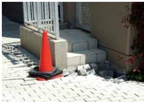
まず、建物自体については、一部亀裂の入った箇所もあるが、大部分は建物自体の被害ではなく、外構部との地盤のズレ/段差によるものが多かった。建物は固い地盤まで届く杭で堅牢に支持されているが、外回りは液状化に伴う地盤の沈下が生じ、そのズレにより、写真左上や写真中上のように被害が発生している。
