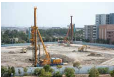
超大型の杭打ち機。ここには一時4台もの杭打ち機が一度に動いていた。
