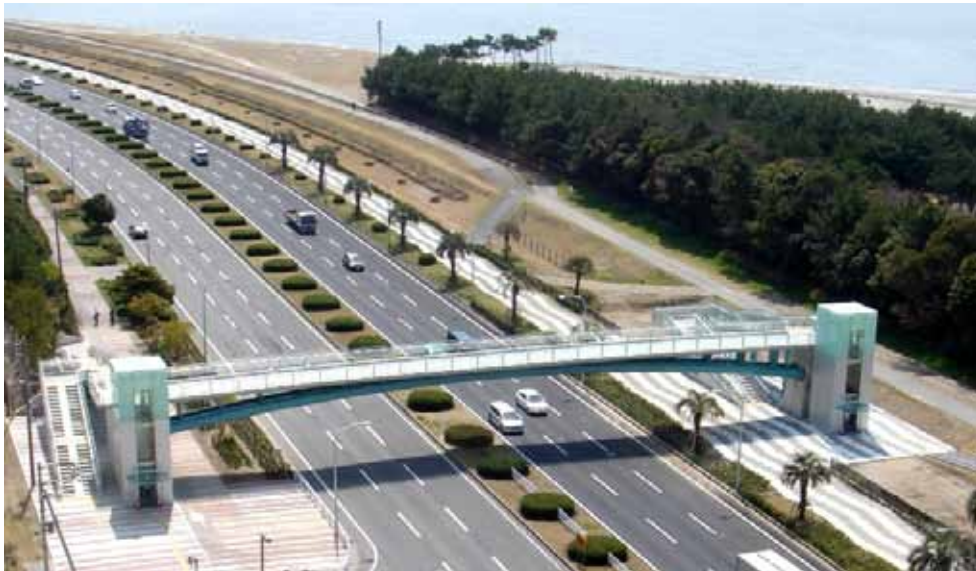
完成したシーサイドデッキ全景（マリンフォートの横山英昭さん撮影）
