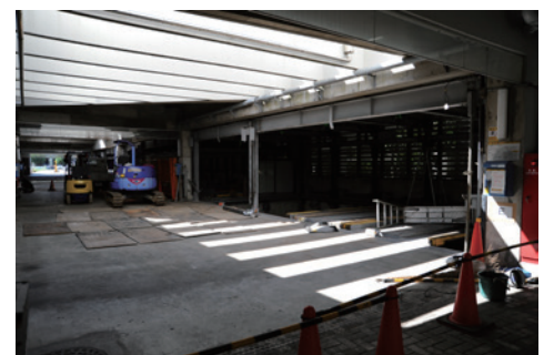
（写真上）外部からの進入禁止のため新しく設置されたゲート。
