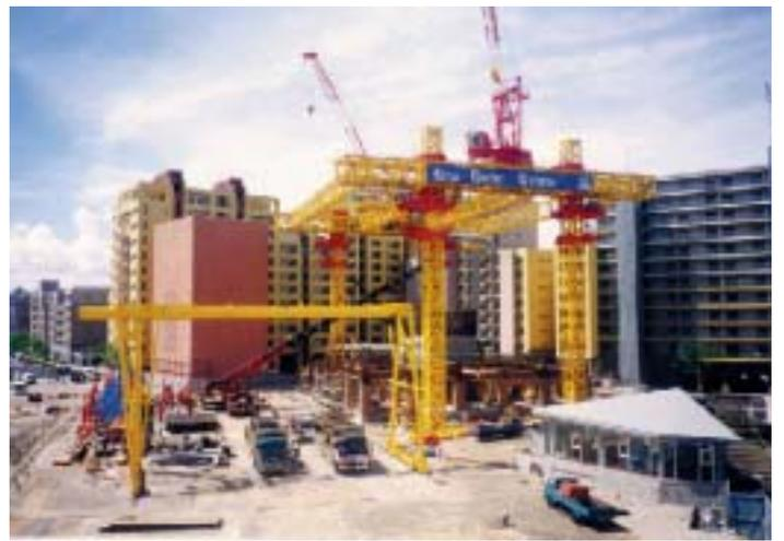
ニュースマートシステム全貌（建設開始当初。左下の鉄工所のような現場が「サイトファクトリー」です。写真提供：清水建設）
