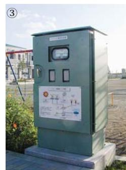
③発電設備近くにある制御盤。発電量を示すメーターと学習に使うのを想定したコンセントが付いている。
